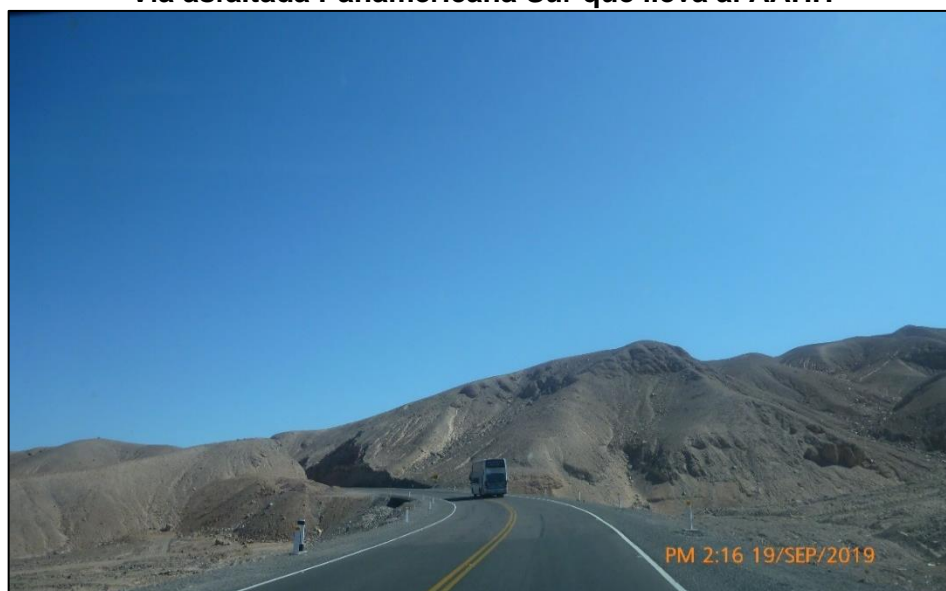
Fotografía N° 3. 24 Vía asfaltada Panamericana Sur que lleva al AAHH
