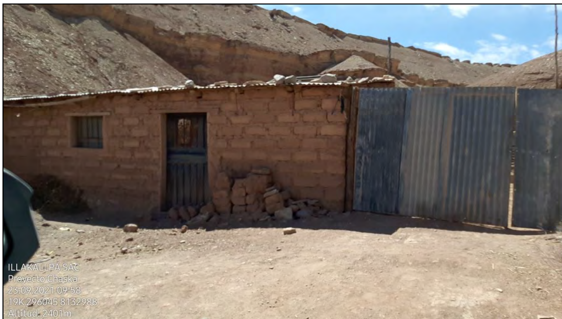
Foto 3.13. Vistan exterior de las viviendas Jaguay Chico
