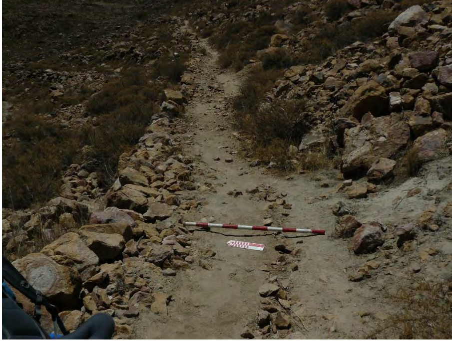
Foto 20.- Vista este. Camino prehispánico que atraviesa el sistema de andenería. Presenta arquitectura formal consistente en muro de contención hacia el norte.
