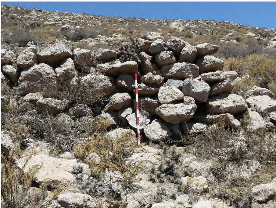
Foto 13.- Vista sur. Detalle frontal de muro de contención de andén.
