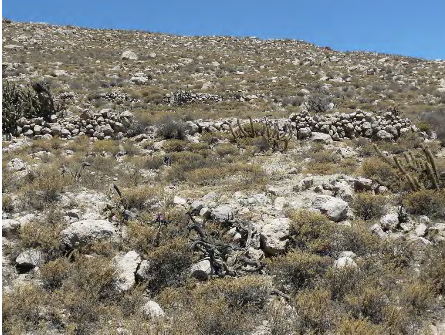
Foto 16.- Vista suroeste. Vista de andenería de muros de contención rectos, dispuestos en ladera de cerro de manera escalonada,
