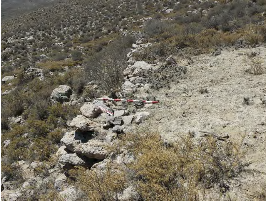
Foto 12.- Vista este. Detalle de ancho de muro de contención de andén.
