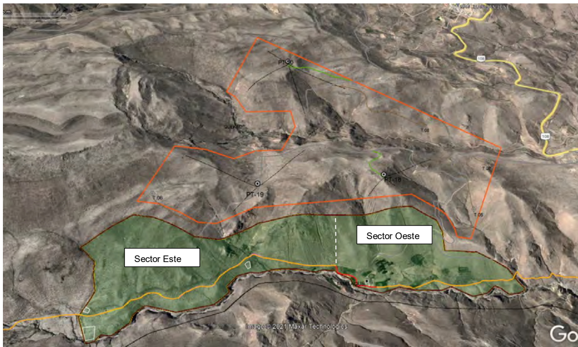
Figura 2.- Vista general del Polígono N°3 del Proyecto Chaska (línea naranja) y el Paisaje Cultural Arqueológico (polígono sombreado en verde), con sus respectivos sectores.
