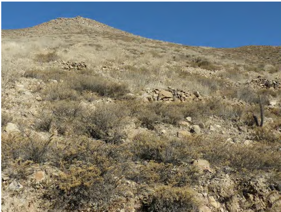
Foto 8.- Vista suroeste. Detalle de muros de contención de andenería, sobre ladera de cerro.
