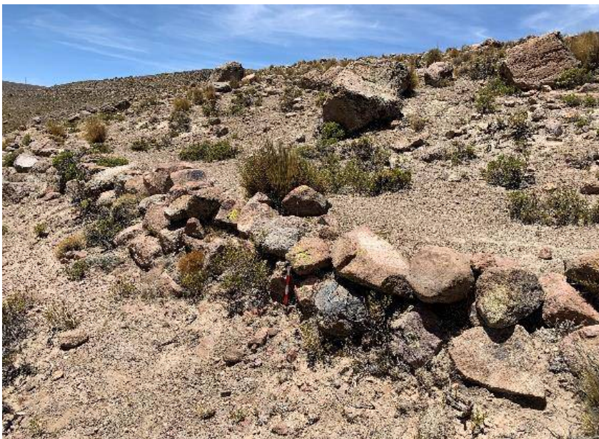
Foto 6-37: Detalle del muro de contención del Segmento 1
