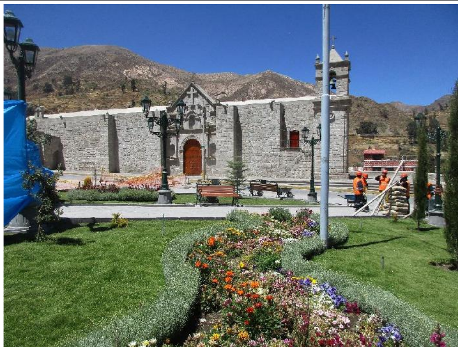
Foto N° 1: Infraestructura principal-Iglesia del Centro Poblado Carumas.
