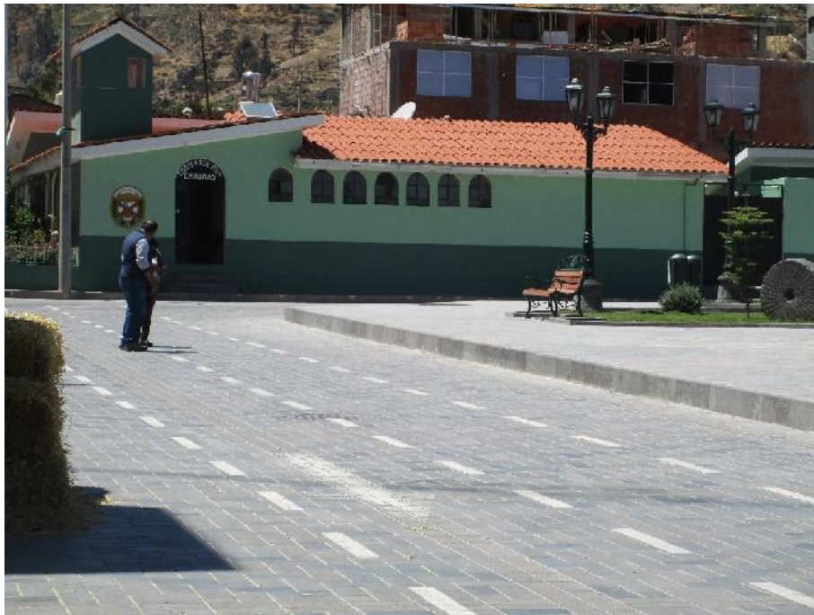
Foto N° 3: Infraestructura principal-Comisaría Centro Poblado Carumas.
