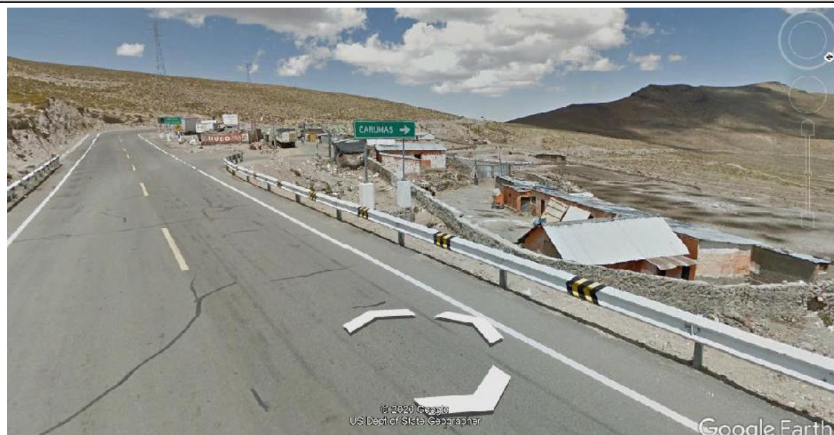
Foto N° 15: Anexo Chilligua, ubicado en el desvío de la carretera nacional hacia el centro poblado Carumas
