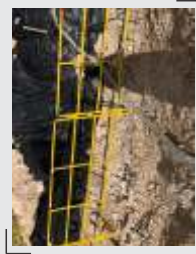
Habilitación de pozas de sedimentación
