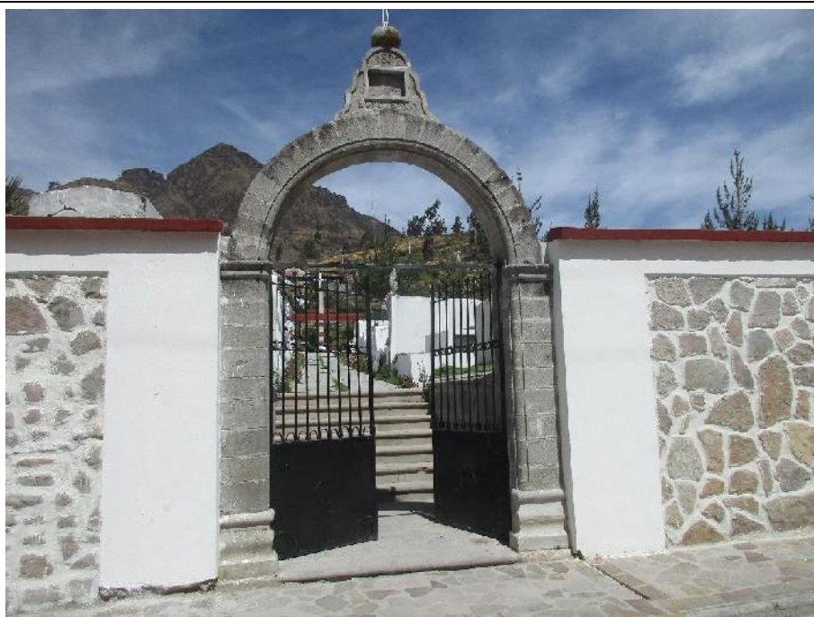
Foto N° 2: Infraestructura principal-Cementerio del Centro Poblado Carumas.
