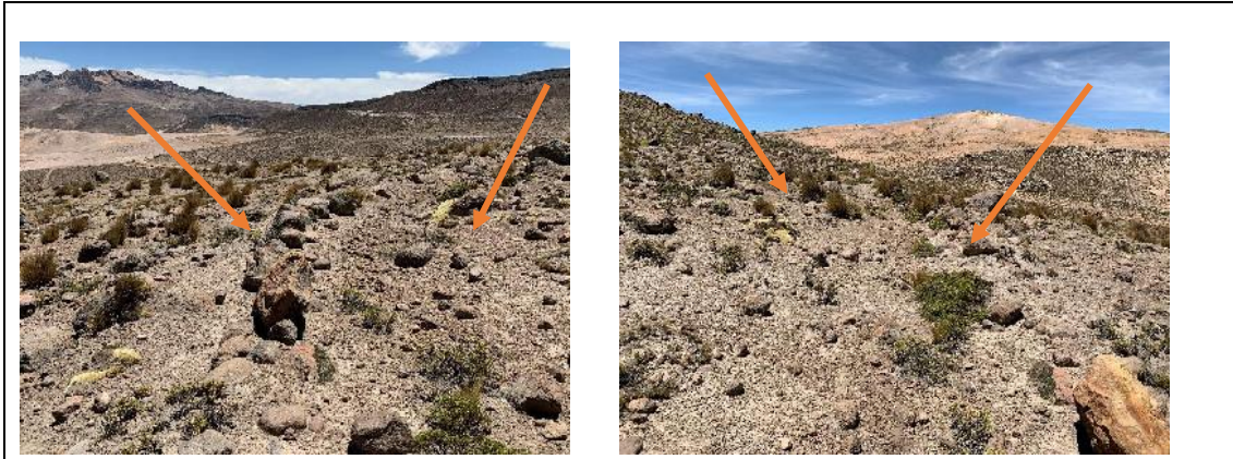
Foto 7 y 8.- Vista detalle de calzada del segmento de camino.
