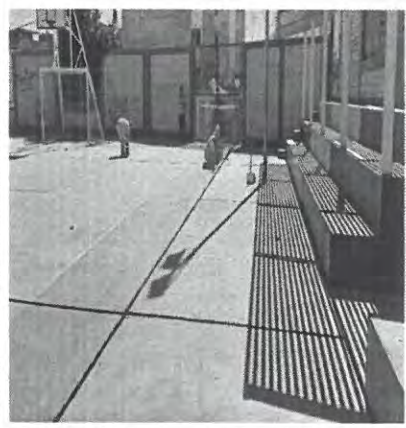
ANTES DE LA INTERVENCIÓN
