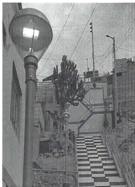
DESPUES DE LA INTERVENCIÓN
