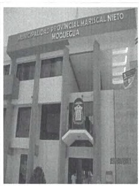
ANTES DE LA INTERVENCIÓN
