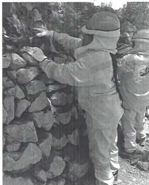
DESPUES DE LA INTERVENCIÓN
