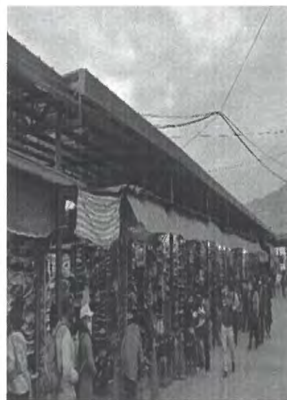
DESPUES DE LA INTERVENCIÓN
