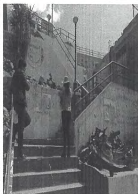
ANTES DE LA INTERVENCIÓN
