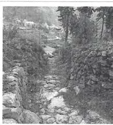
DESPUES DE LA INTERVENCIÓN
