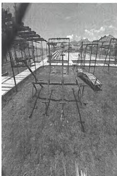
ANTES DE LA INTERVENCIÓN
