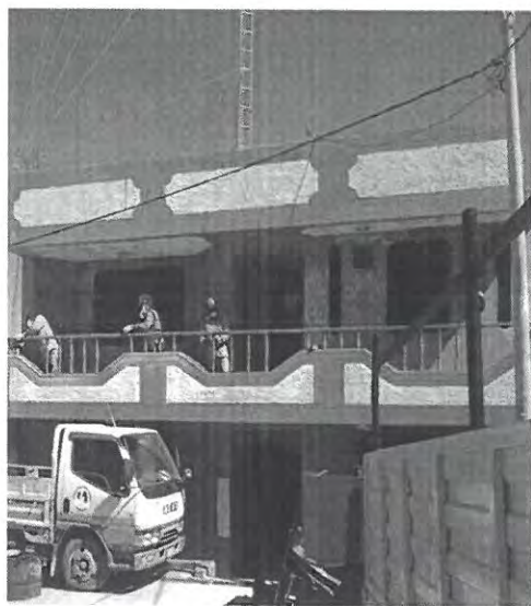
ANTES DE LA INTERVENCIÓN
