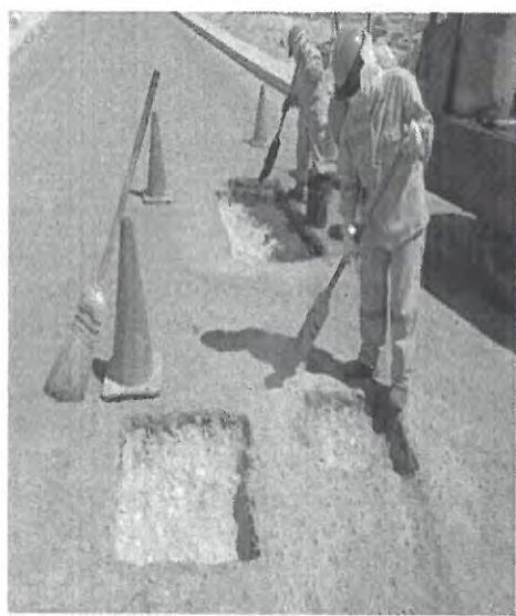
ANTES DE LA INTERVENCIÓN
