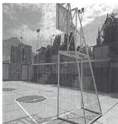
DESPUES DE LA INTERVENCIÓN
