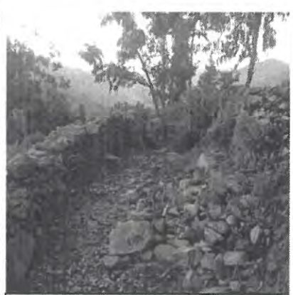
ANTES DE LA INTERVENCIÓN
