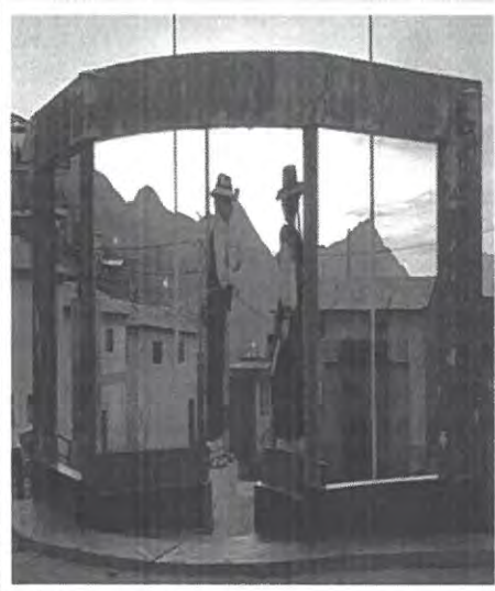
ANTES DE LA INTERVENCIÓN
