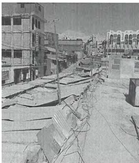
ANTES DE LA INTERVENCIÓN
