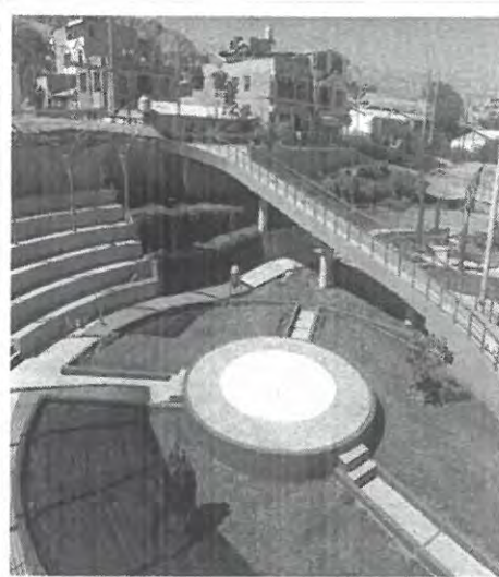
DESPUES DE LA INTERVENCIÓN
