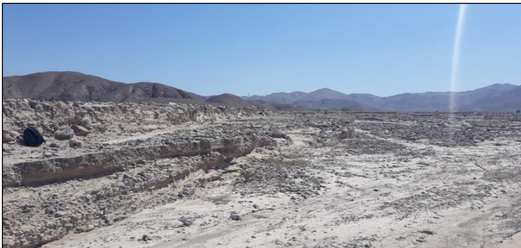
Imagen N° 7.1 - 13: Se observa una sección de origen cuaternario con materiales producto de aluviones – zona de quebrada guaneros
