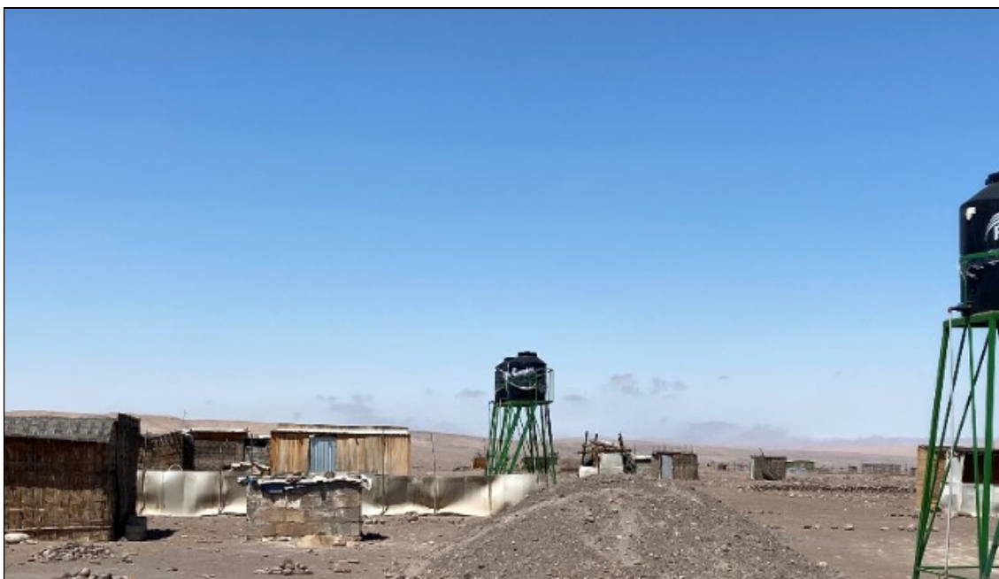
Foto 3.3.4. Tanques de las viviendas para el uso de agua en el P.D. Clemesí (AISI)
