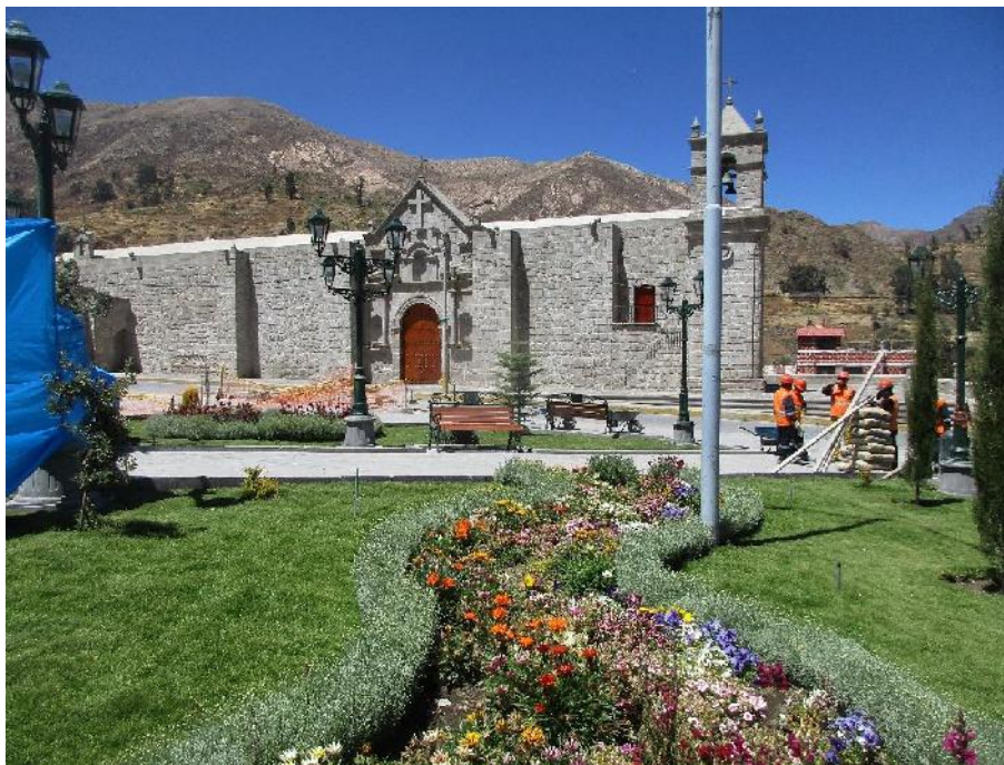
Foto N° 1: Infraestructura principal-Iglesia del Centro Poblado Carumas.
