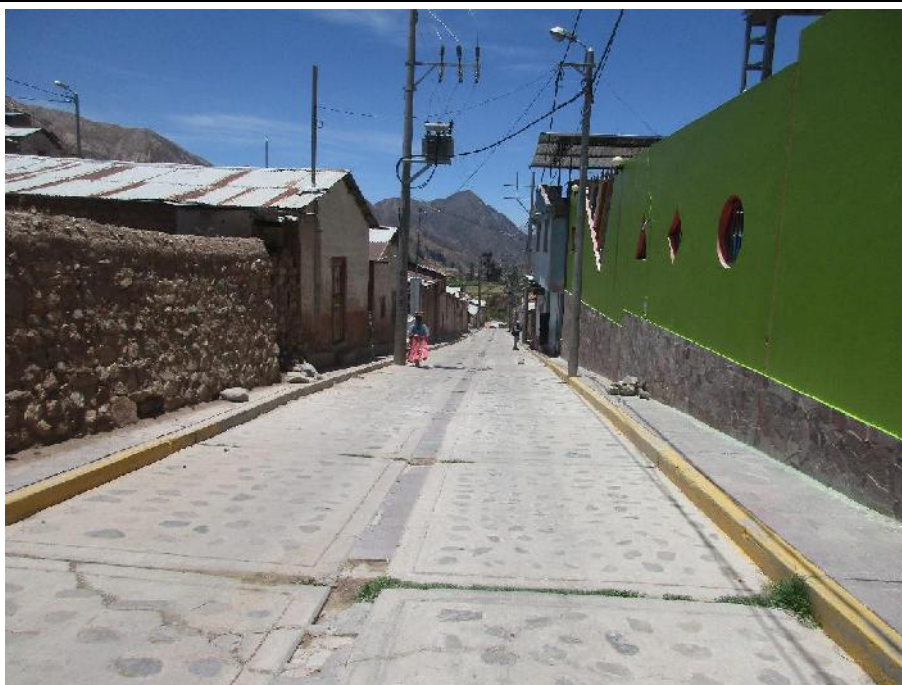
Foto N° 8: Infraestructura principal-Calles con alumbrado eléctrico y antenas de cable en el Centro Poblado Cambrune.
