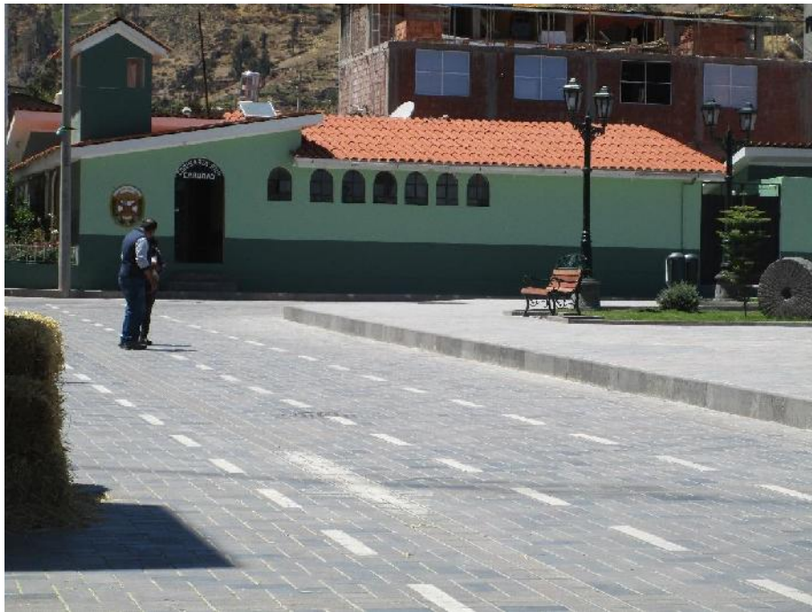
Foto N° 3: Infraestructura principal-Comisaría Centro Poblado Carumas.
