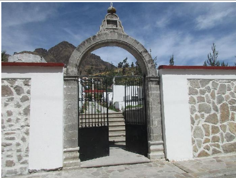
Foto N° 2: Infraestructura principal-Cementerio del Centro Poblado Carumas.
