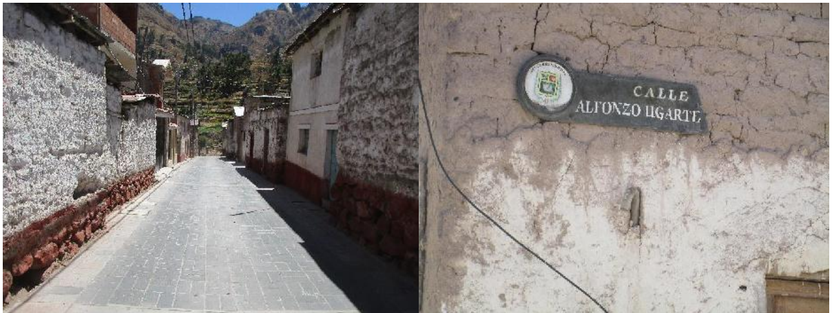
Foto N° 4: Infraestructura principal- Calle Centro Poblado Carumas(izquierda) y Calle principal Centro Poblado Carumas (derecha).
