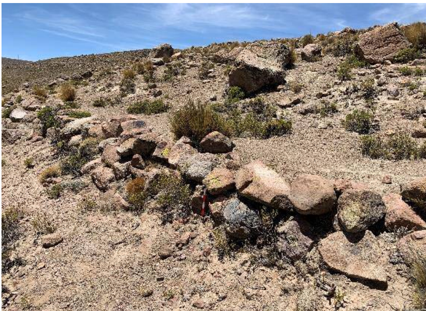
Foto 6-37: Detalle del muro de contención del Segmento 1
